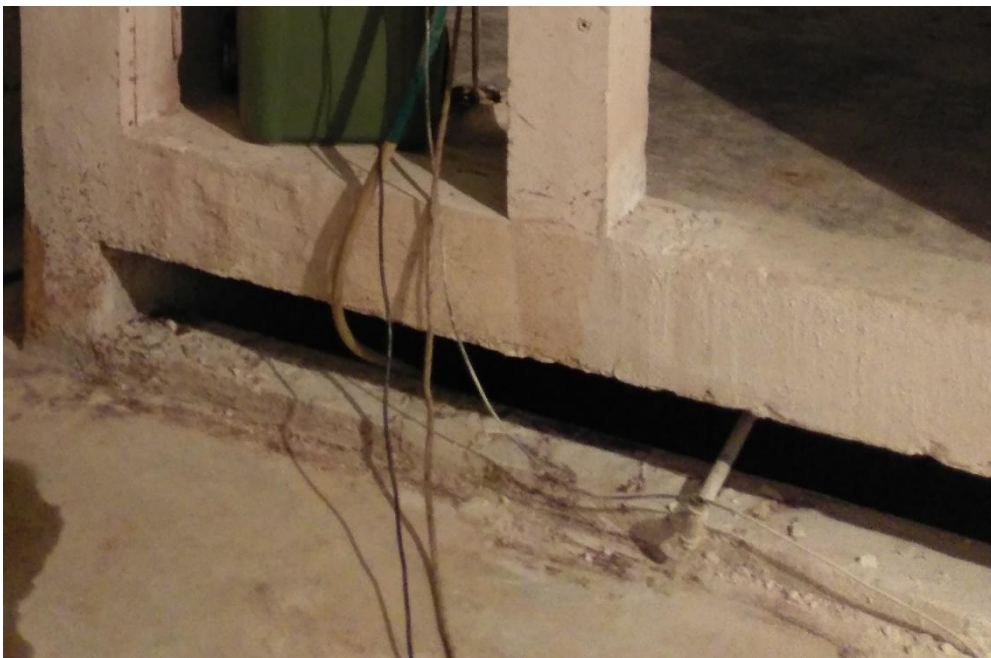
Rysunek 4 Podmurówka do uzupełnienia z widocznym w głębi zbiornikiem zapasowym
