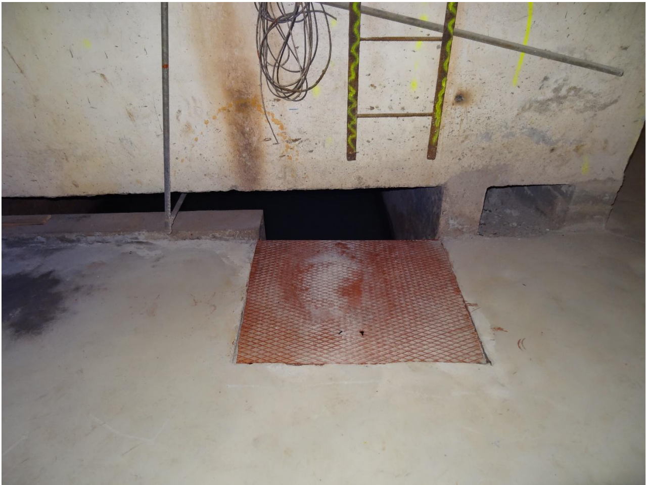
Rysunek 5 Kłapa wjazdu do zbiornika zapasowego
